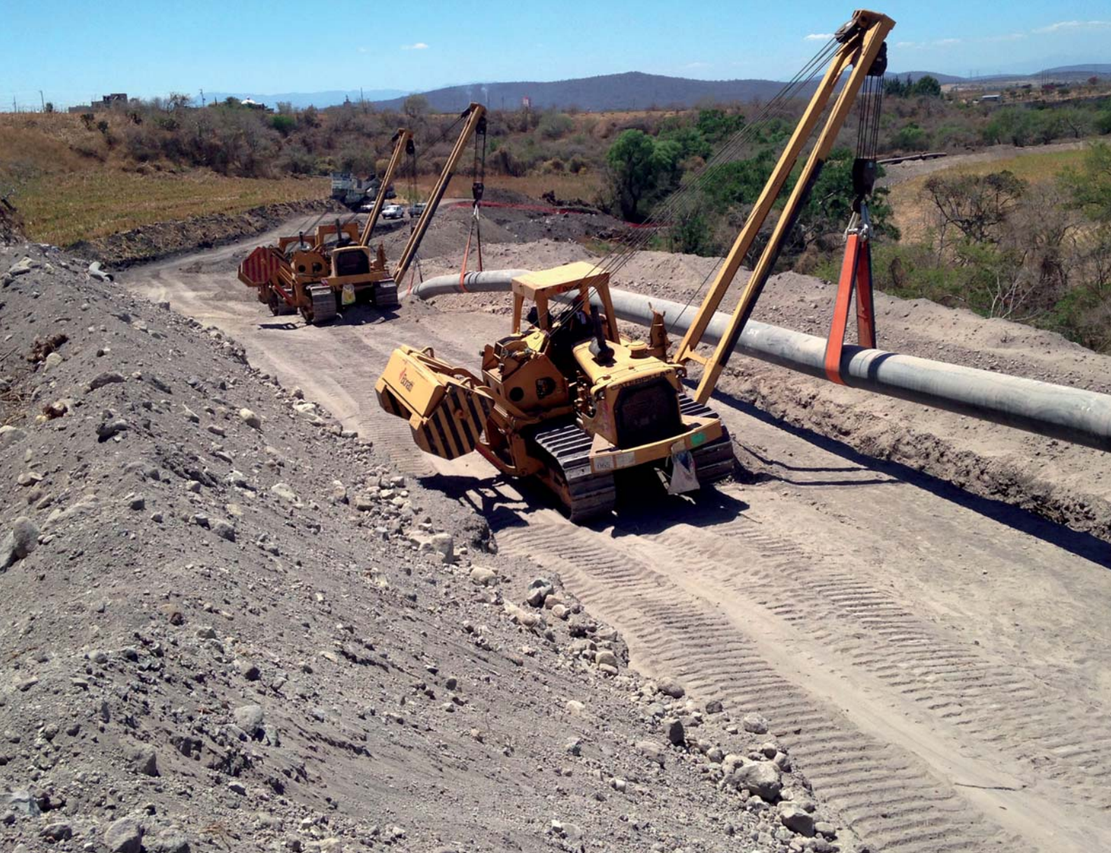
Gasoduto Morelos (México)
