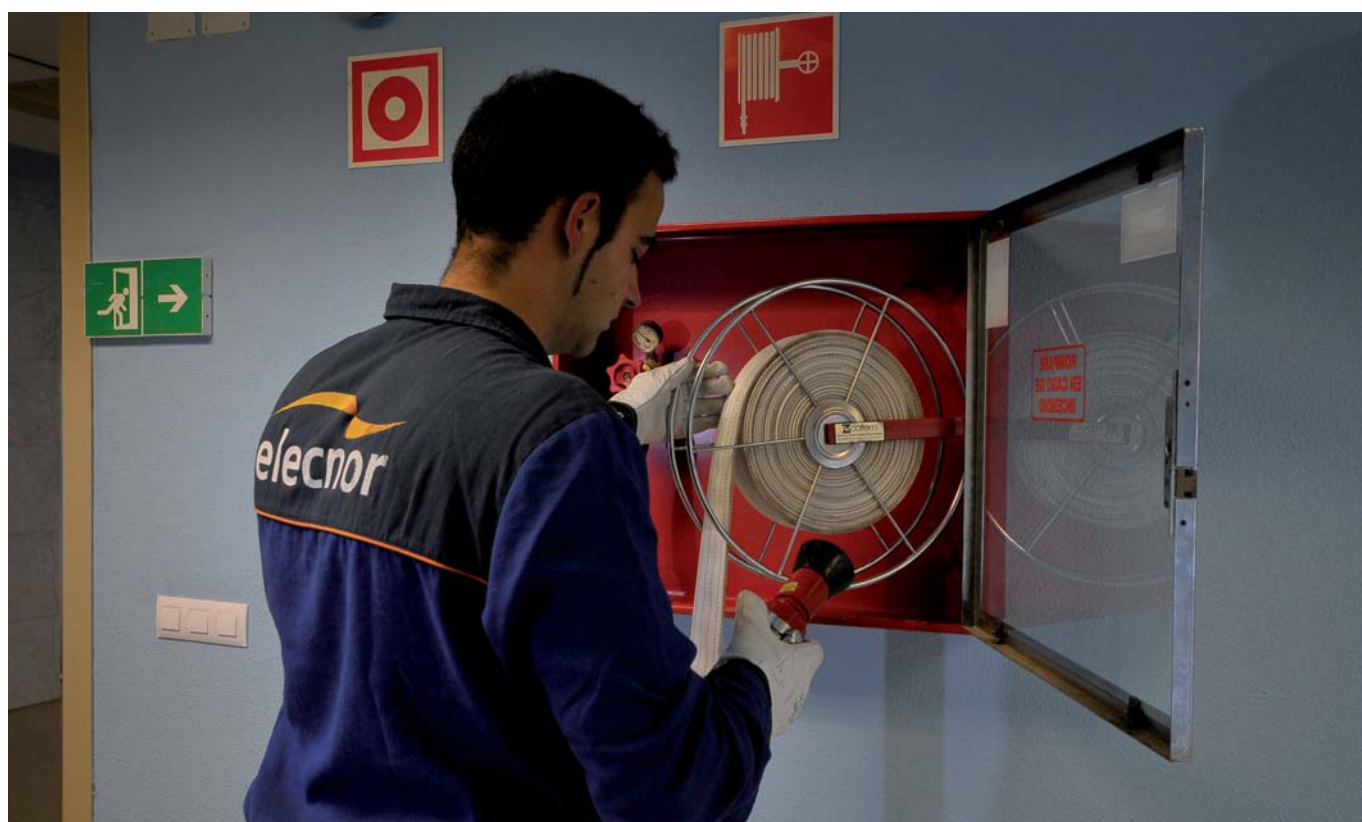
Manutenção do Hospital Carmen y Severo Ochoa em Cangas del Narcea (Astúrias)
