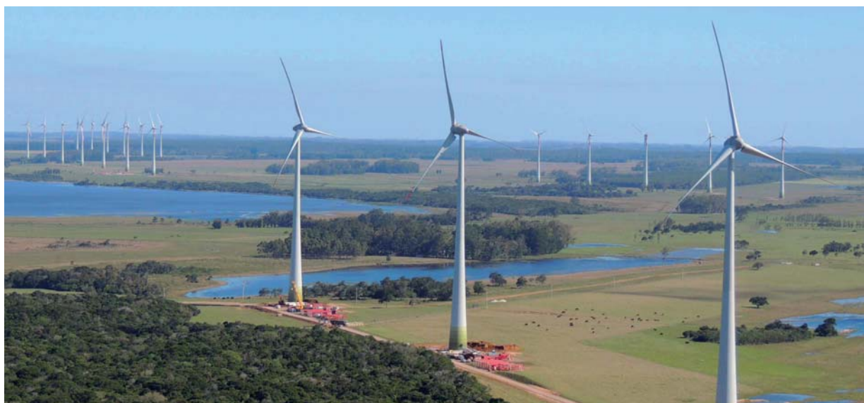
Parques Eólicos Dois Índios (Brasil)
