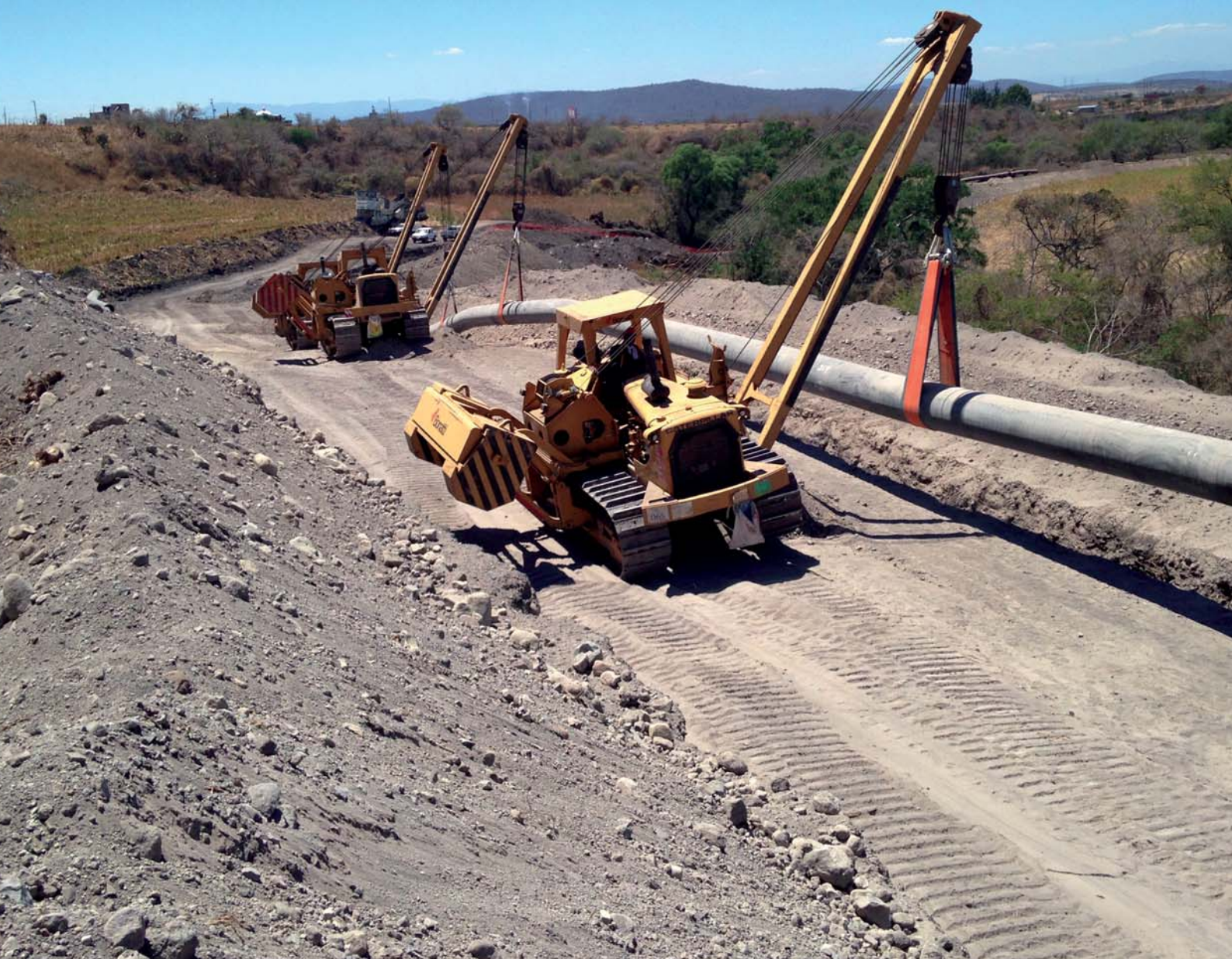
Morelos gas pipeline (Mexico)
