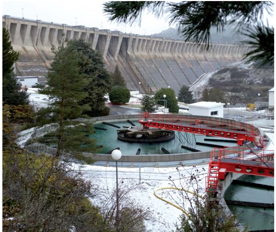
Navacerrada WWTP (Madrid)
