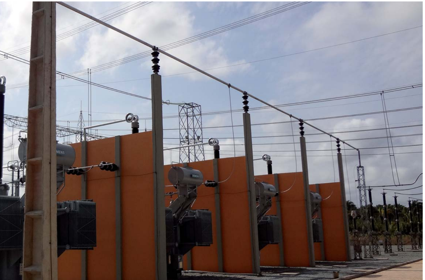
Sous-station Miranda II (Brésil)
