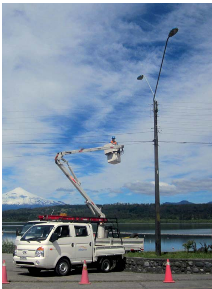
Éclairage public dans la municipalité de Villarrica (Chili)
