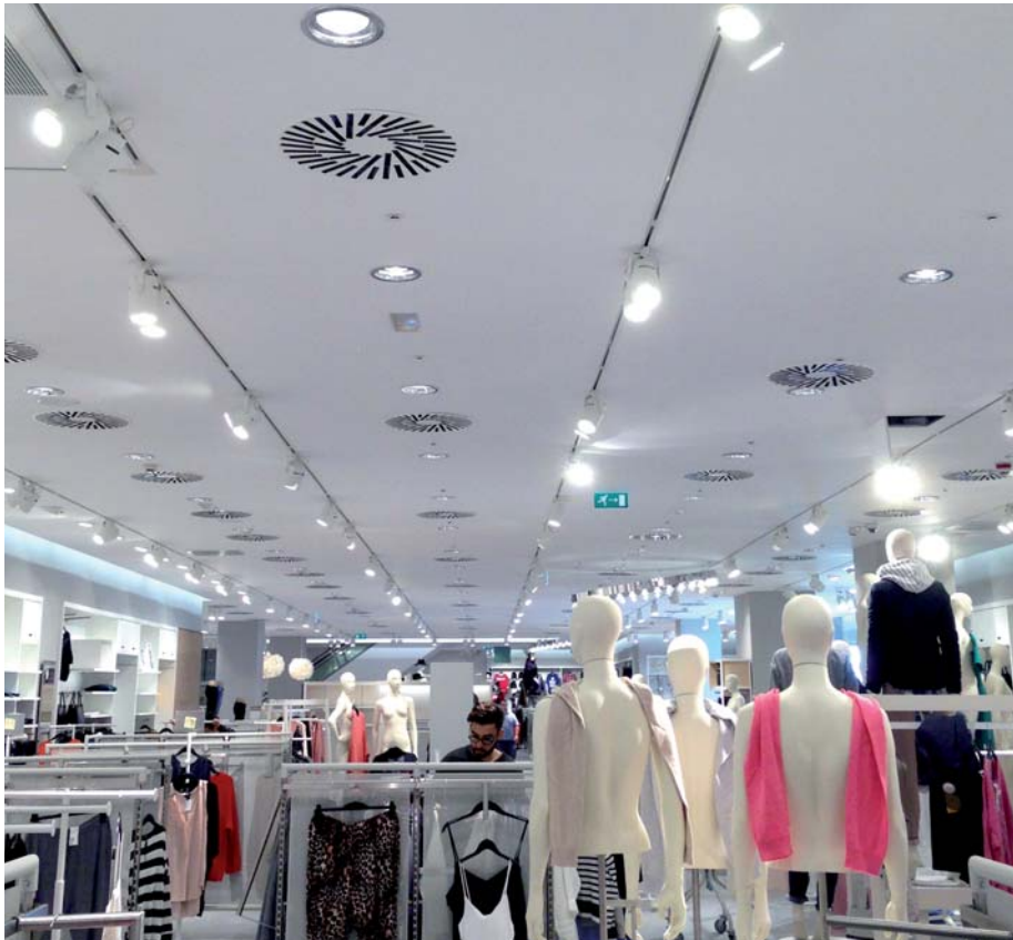
Installations dans H&M C.C. Nervión Plaza (Séville)
