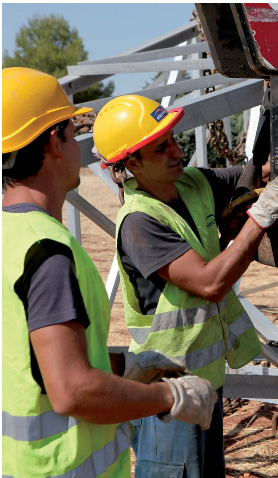
Ligne aérienne haute tension à double circuit de 45 kV Alarcos-Piedrabuena (Madrid)
