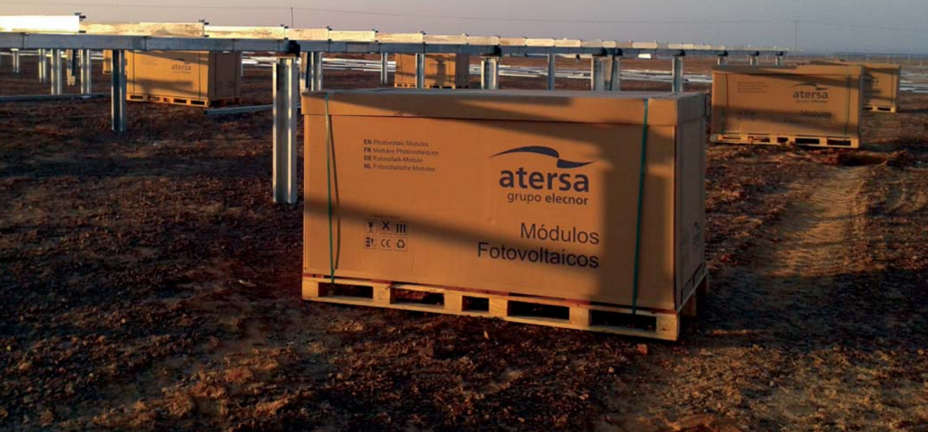
Parc solaire d'Azrak (Jordanie)
