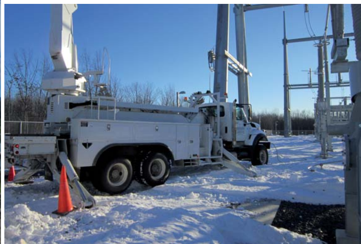
Travaux d'Elecnor Hawkeye (États-Unis)
