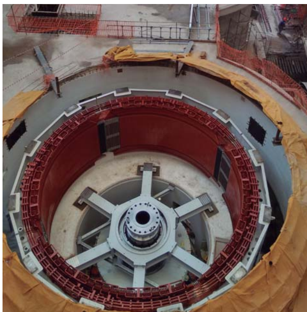
Central Hidroelétrica Cambambe 2 (Angola)
