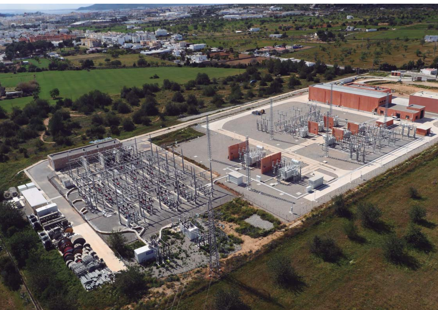
Subestação 132 kV em Torrent (Ibiza)
