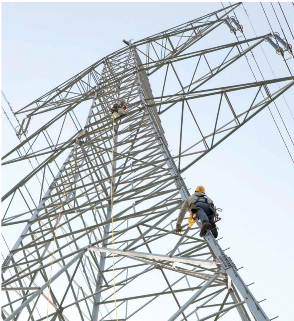
Substituição de OPGW em Los Barrios (Cádiz)
