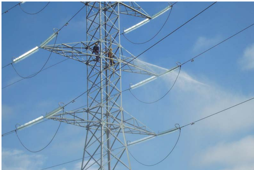
Lavagem de isoladores com água desionizada
