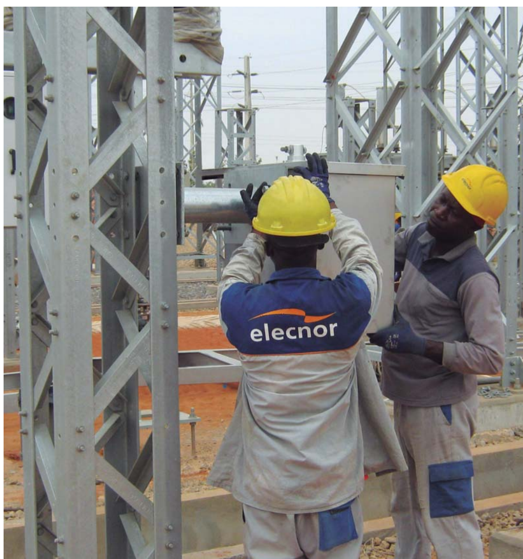
Ampliação da subestação Camama 220/60 kV (Angola)
