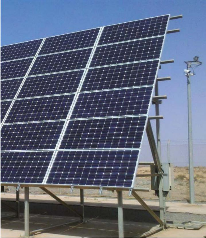
Instalación solar para protección catódica y control de válvulas de gasoducto.
